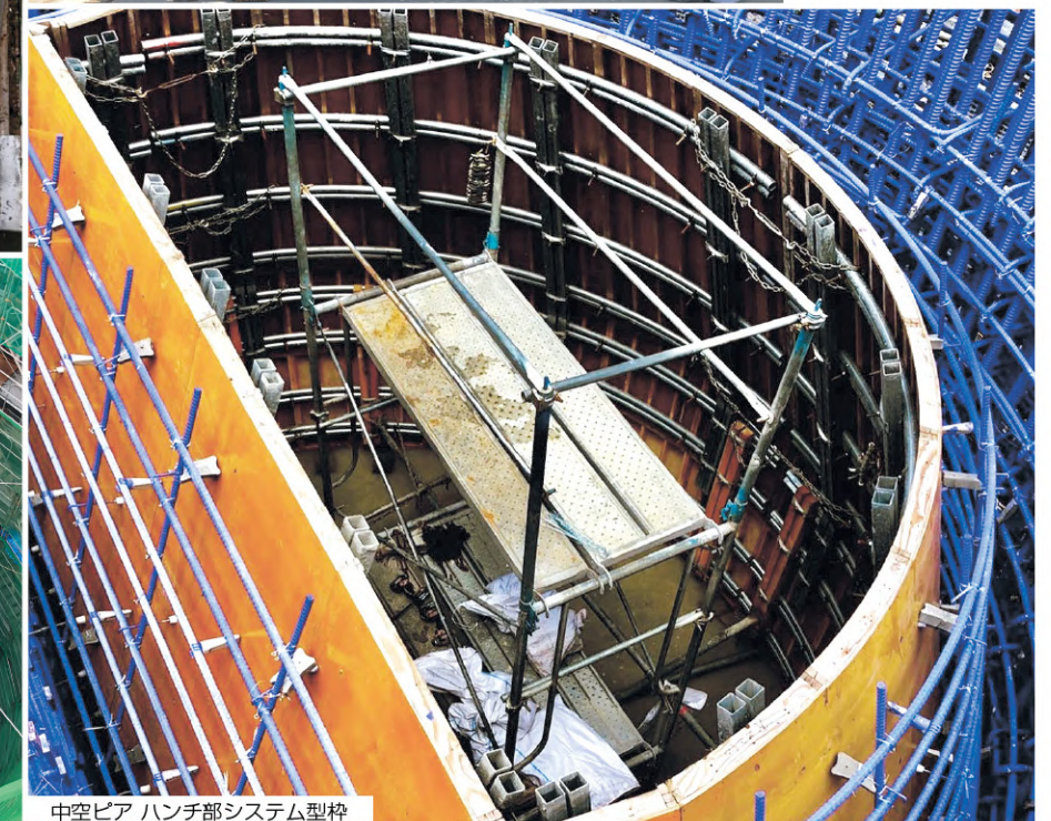
中空ピア ハンチ部システム型枠
