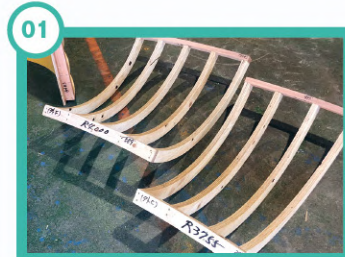
01 構造物の形状の骨組みを製作
