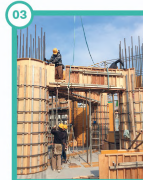
03 現場で組み立て
