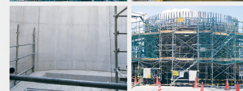
【立坑・ケーソン】ノーセバ工法（高洋商会オリジナル工法）
