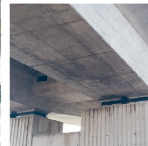
上部工仕上がり
