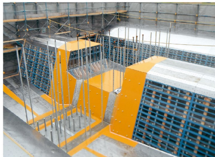
上部工全面施工
