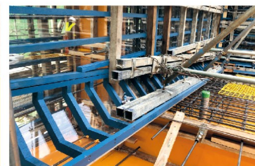
ワーゲン上部工
