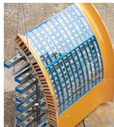
橋脚下部工(梁底アール部)
