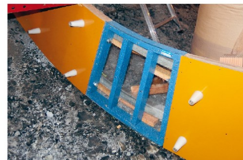
トンネルインパート
