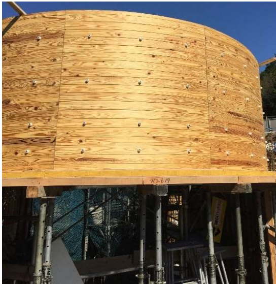
杉板本実型枠(円形建込み)
