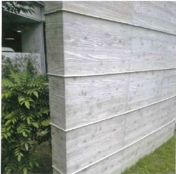
杉板本実型枠(仕上がり)
