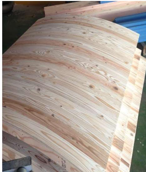
杉板本実型枠(円形加工)
