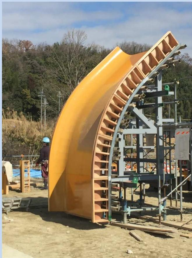
架台と型枠の丘組完成
