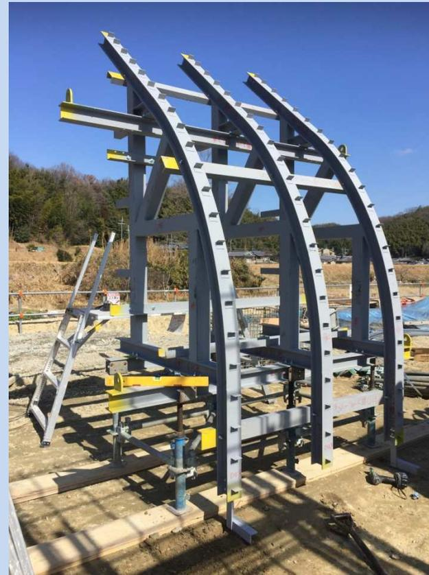
指定のボルトナットにより架台を組立て、寸法チェック
