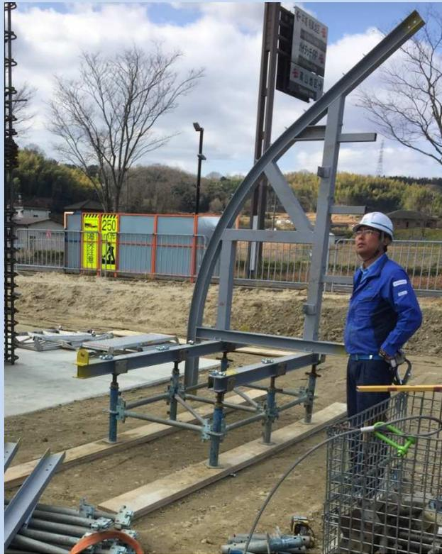
支保工の位置、レベルを確認して大引き材を水平に並べる
