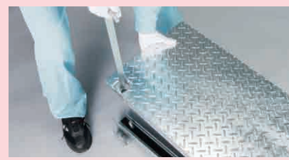
③グレーチングを引き上げます。
