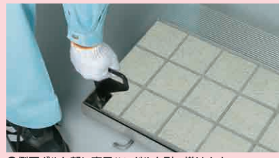
②側面ボルト部に専用ハンドルを引っ掛けます。
