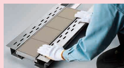
③蓋を上から押さえて受枠にセットします。 ⚠手を挟まないように注意してください。
