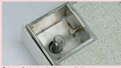
①キャップ、ナット、ワッシャー、ゴムワッシャー、スペーサーを取り外します。
