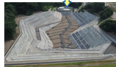
廃棄物最終処分場全景
